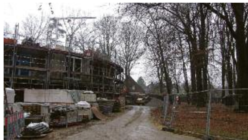
Auch gegen den Bau von 66 günstigen Wohnungen für Familien in Iserbrook wurde ein Bürgerbegehren eingeleitet – erfolglos. Anwohner befürchteten die Abholzung eines ganzen Waldes und mehr Anwohner-Verkehr über ihre eigene Straße.
