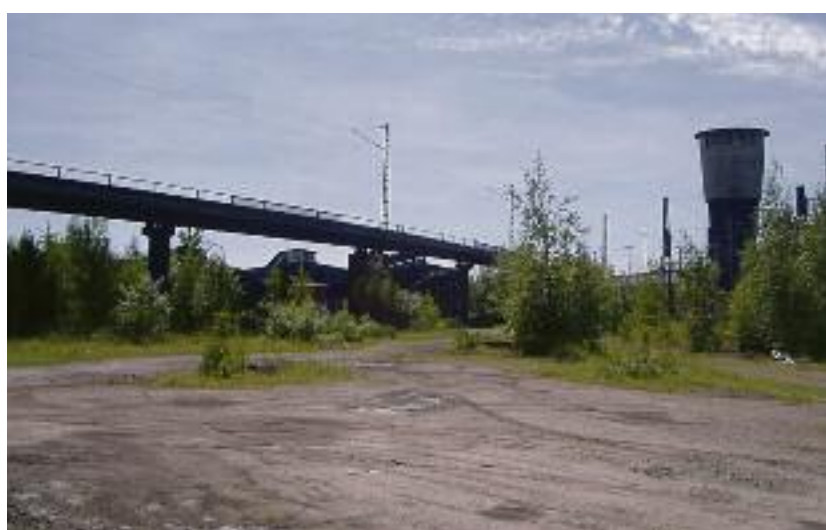
Der ehemalige Wasserturm, hier rechts im Bild, wird als Symbol in „Altona Mitte“ bestehen bleiben.
