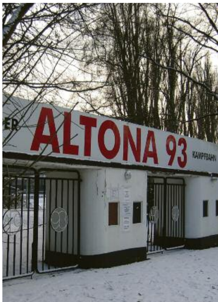
Dringend sanierungsbedürftig: Die Adolf-Jäger-Kampfbahn an der Griegstraße Foto: Altona 93
