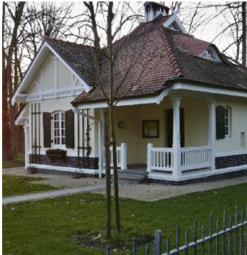
Das kleine Pförtnerhäuschen am Eingang zum Jenischpark steht für kleine Veranstaltungen zur Verfügung. Foto: Köhler
